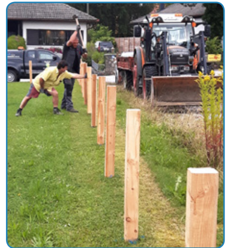
Bauhofmitarbeiter beim Zaun-Aufbau.
