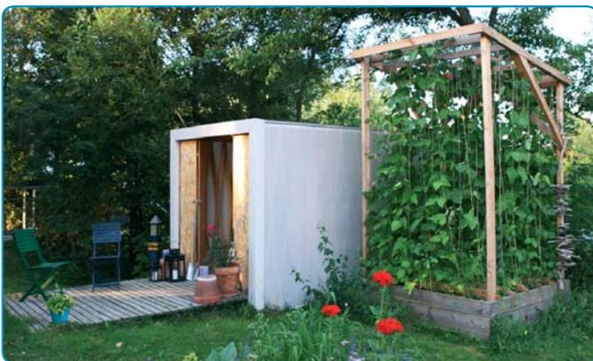
Gerätehaus und Bohnturm – zwei Bauwerke, zwei Cousins. Das Gartengerätehaus besteht aus einer Holzrippenkonstruktion mit LKW-Plane. Geplant und gebaut vom jungen Pettenbacher Architekt Florian Radner. Am Bohnturm ranken sich verschiedene Bohnensorten an Schnüren empor. Erfindung und Ausführung des Cousins Josef Pitschmann.
