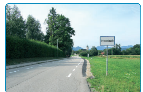
Radfahrstreifen Welser Straße
