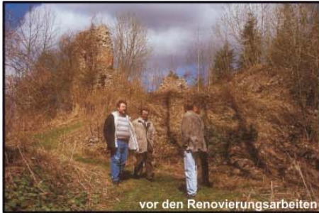
vor den Renovierungsarbeiten
